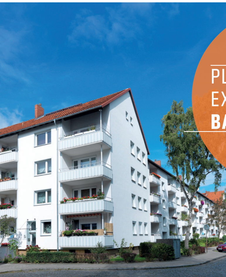
Zustand nach der Sanierung
